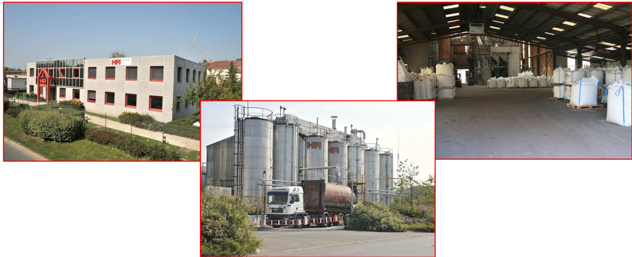
Bild 1: Ansichten aus den beiden Werken von HA France (Pont Sainte Maxence und Bourron Marlotte).
